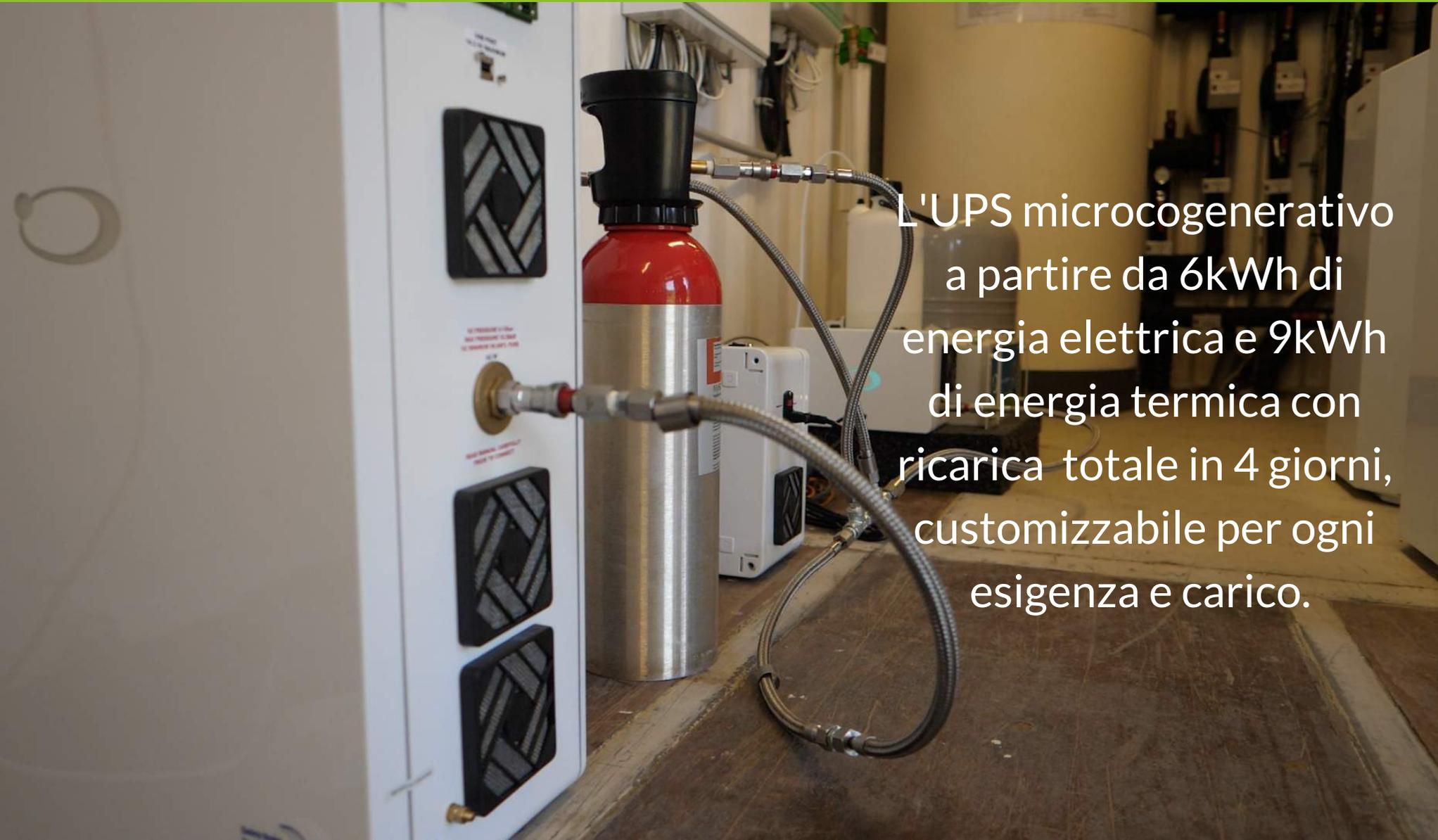
L'UPS microgenerativo a partire da 6kWh di energia elettrica e 9kWh di energia termica con ricarica totale in 4 giorni, customizzabile per ogni esigenza e carico.
