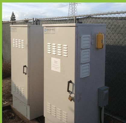
MFC è silenzioso e ha emissioni di carbonio minime. La sua fuel-cell integrata utilizza un processo elettrochimico per generare energia elettrica senza combustione. Il combustibile utilizzato è una miscela di metanolo e acqua a bassa volatilità.
